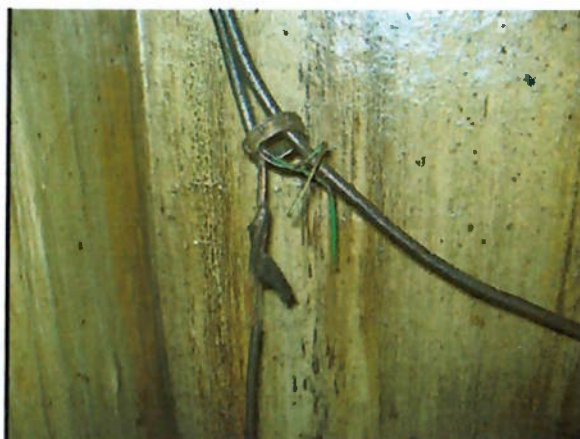
Figura 45 - Cabos desprotegidos
