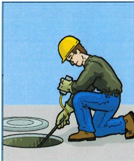
Figura 18 - Trabalhador fazendo o monitoramento da atmosfera Fonte: Fundacentro - Espaços Confinados – Livreto do Trabalhador
