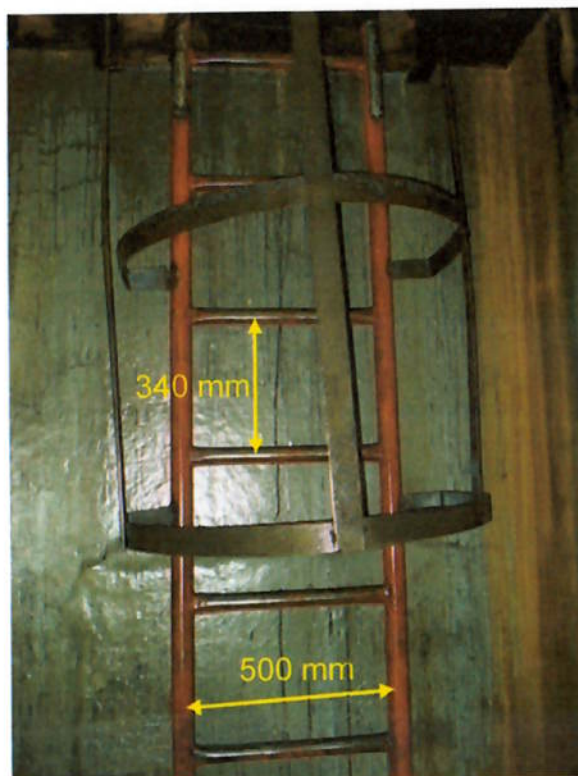
Figura 53 - Escada tipo marinheiro vista pelo lado de dentro do porão
