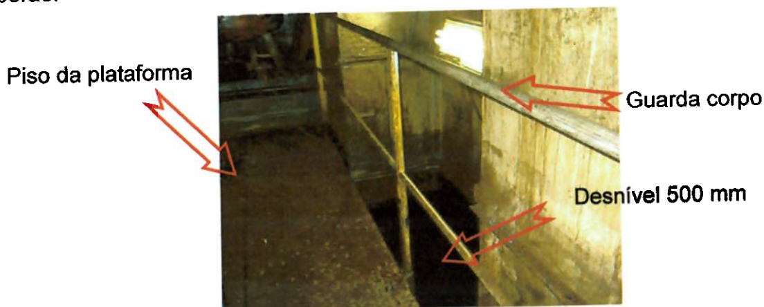
Figura 58 - Piso da plataforma em aço dentro do porão
