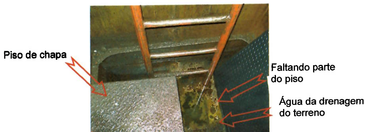
Figura 57 - Parte inferior da escada tipo marinheiro – dentro do porão
