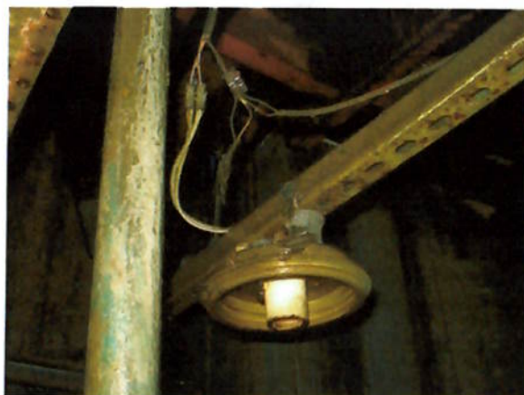
Figura 44 - Emendas expostas e luminária em péssimas condições
