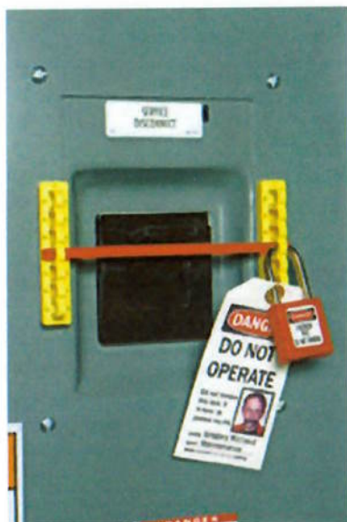
Figura 15 - Aplicação do uso de etiqueta e cadeado em dispositivo elétrico Fonte: Seton
