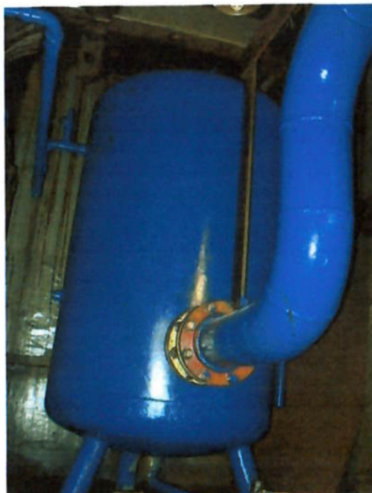
Figura 69 - Vaso de pressão da almofada - pintura em fase final
