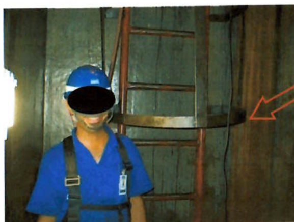
Figura 54 - Altura do guarda corpo da escada tipo marinheiro x altura do trabalhador
